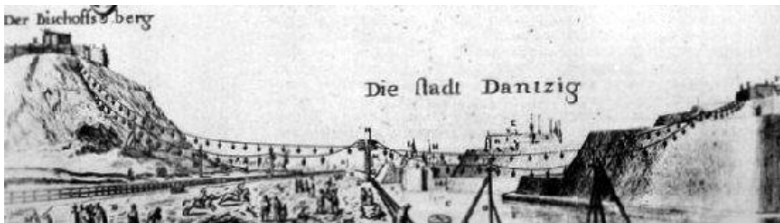
Ein von Adam Wiebe, zur Beförderung des Erdreiches vom Bischoffsberg, zur im Ausbau befindlichen Bastion Berg, gebauter Eimertransporter.
