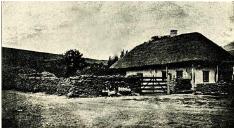
Малорусская хата изъ дикаго камня Слavyаносербск. у. и дворъ съ каменною изгородью.
